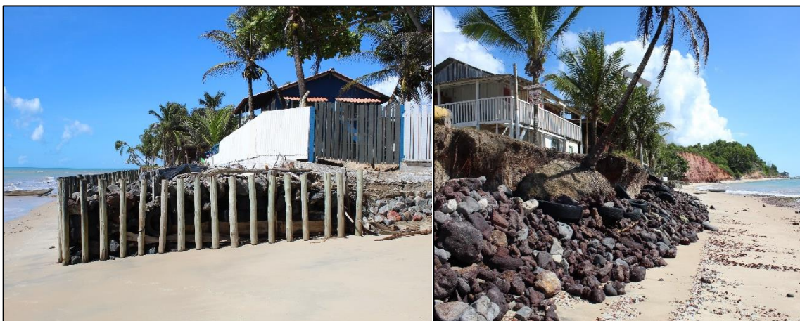
Figura 4. Métodos utilizados pelos moradores para evitar a abrasão das ondas. (Praia da Paixão, município de Prado, 2024)
