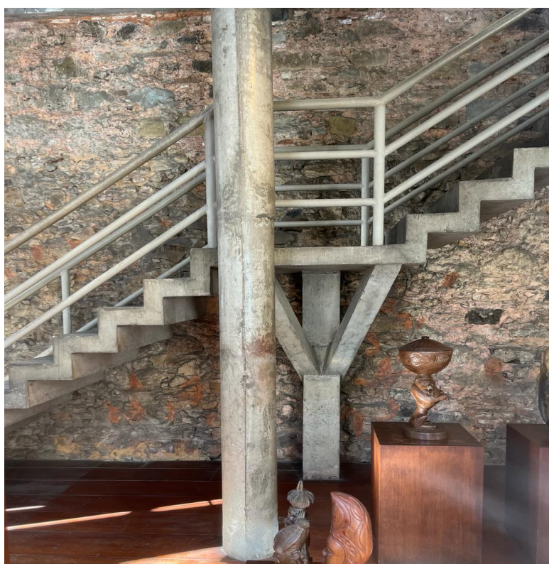
Figura 3: A escada plissada tem uma estrutura independente com um pilarete que se divide em dois pilares inclinados, que suportam o patamar e melhoram a estabilidade. Ela foi relatada sobre vigas nos pavimentos térreo e 1º andar, garantindo que a carga seja bem distribuída
