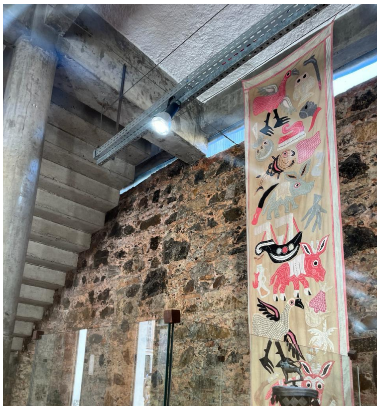
Figura 2: Constatou-se que as vigas estão em balanço, estendendo-se até próximo à parede do muro da cidade da Casa do Benin, em Salvador. Essas vigas não transmitem cargas para a parede antiga.
