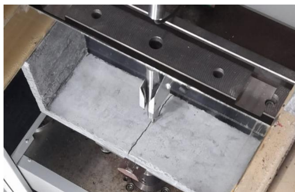
Figura 3- Fissura central no protótipo do banco.
