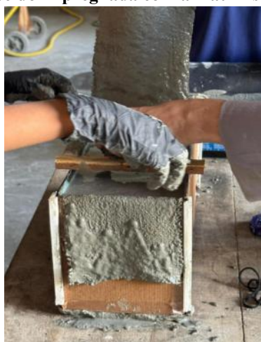
Figura 1- Camada de tecido impregnada com a matriz sendo colocada no molde.
