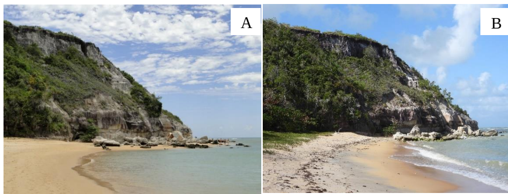
Figura 3. Falésias da praia dos Amores (Setiquara), (A) Falésia registrada em 2017. Fonte: Banco de dados do CONSEPE 033/2016. (B) Falésias registradas em 2025 . Fonte: Autores, 2025
