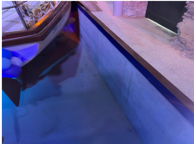
Figura 2: Vista da fundação onde o barco está apoiado, um retângulo parecendo uma estrutura de piscina que com uma fundação bem mais robusta para garantir a integridade das estruturas, feita aparentemente toda em concreto.
