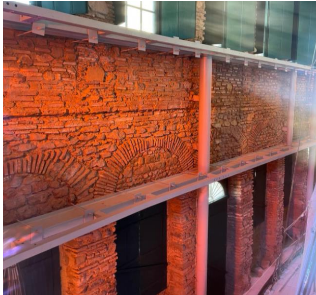
Figura 1: Foto destacando a trama da estrutura nova conectada a antiga, tendo um formato de pórtico formada por pilares e vigas de metal afim de melhorar a segurança do local.
