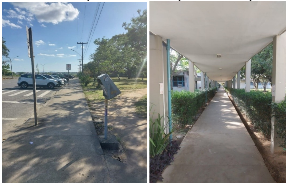
Foto 3 e 4: Falta de rampa com acesso à faixa de pedestres e falta de piso tátil.
